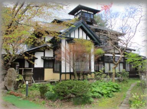
大館市桜橋館_改修前外観
